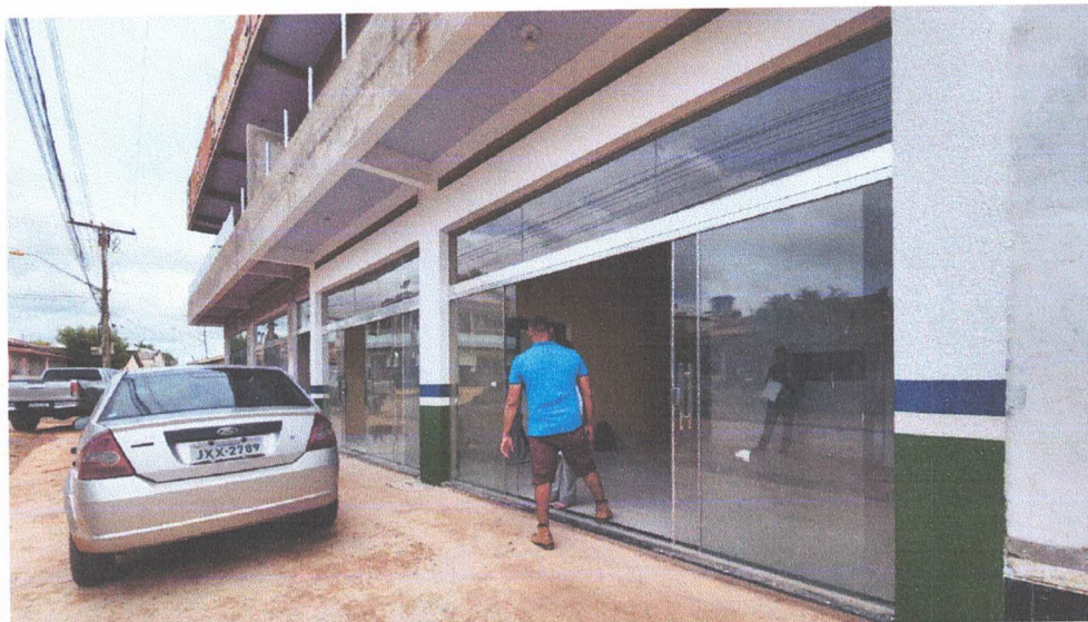
Fotos 01: Fachada e Hall de entrada.
