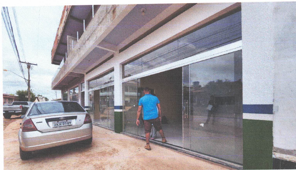
Fotos 01: Fachada e Hall de entrada.
