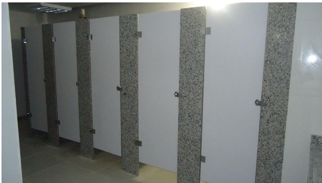
Modelo de instalação de portas e granito nos banheiros
