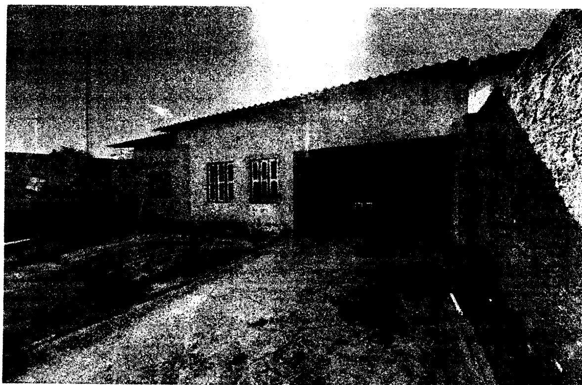
Fotos 01 e 02: Fachada e Hall de entrada com garagem.
