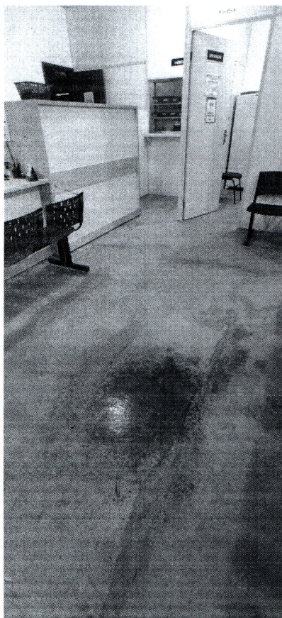
Fotos 10, 11 e 12: Infiltrações em diversos pontos: Hall de entrada, corredor e consultório.
