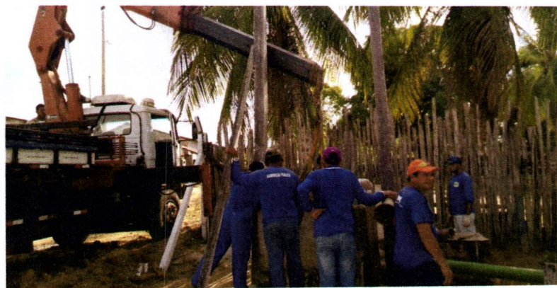
Retirada da Bomba submersa do bairro centro
