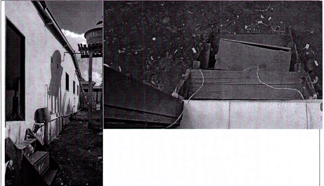
Escada improvisada de acesso externo.
